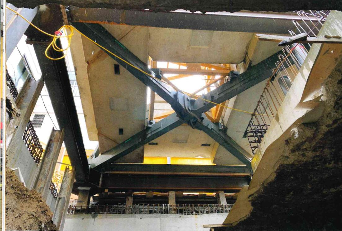
Das Fundament für den Kran bildeten vier Pfähle, die mit einer Stahlkonstruktion verbunden worden sind.
