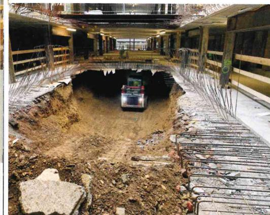
Kompaktlader transportierten das Aushubmaterial zu einer der Montageöffnungen, von wo es ein Hydraulikbagger mit einem Teleskoparm der Firma Winkelbauer und Greifer-Schaufel nach oben beförderte.
