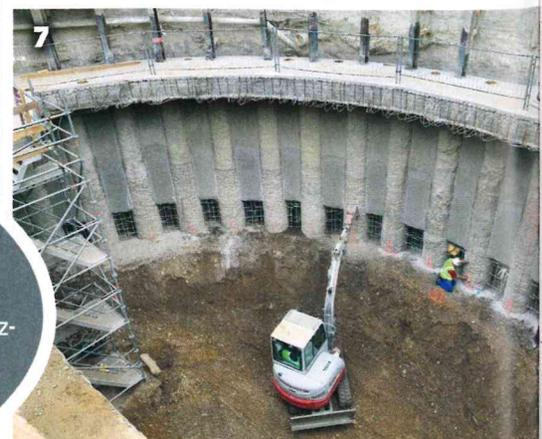
Unsere Bilder zeigen: **(1)** Umlegung der Einbauten. **(2)** Bewehrung der 65 cm starken Decke über dem ersten Untergeschoß. **(3)** Archäologische Grabungsarbeiten. **(4-7)** Herstellung der Bohr- und Hilfspfähle mit den anschließenden Spritzbetonarbeiten. **(8)** Beengte Platzverhältnisse prägten alle Bauphasen. **(9)** Herstellung der Zufahrtsrampe in der Tegetthofstraße.
